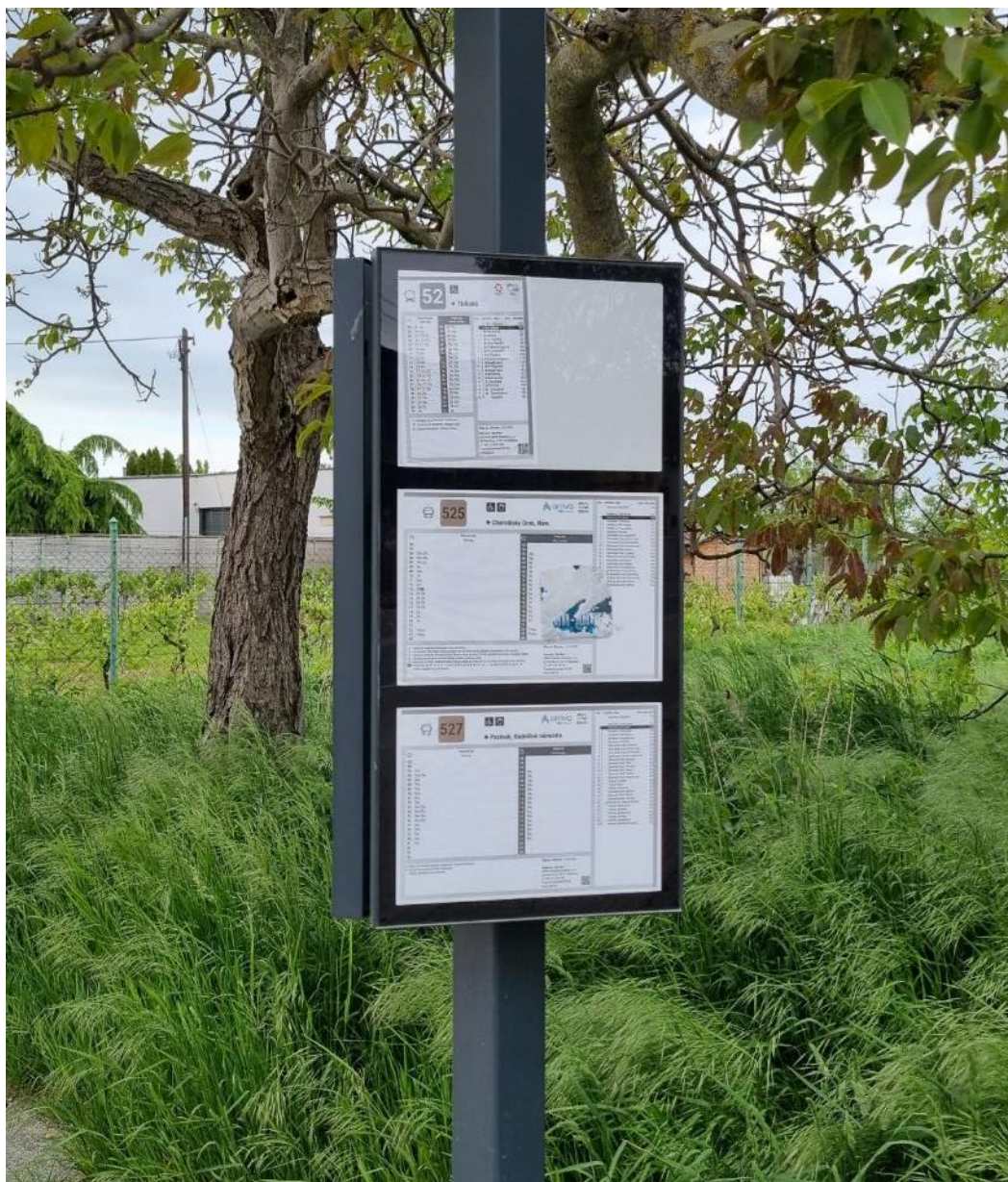
Obrázok 135_Príklad informačnej vitríny osadenej na zastávkový stĺpik
