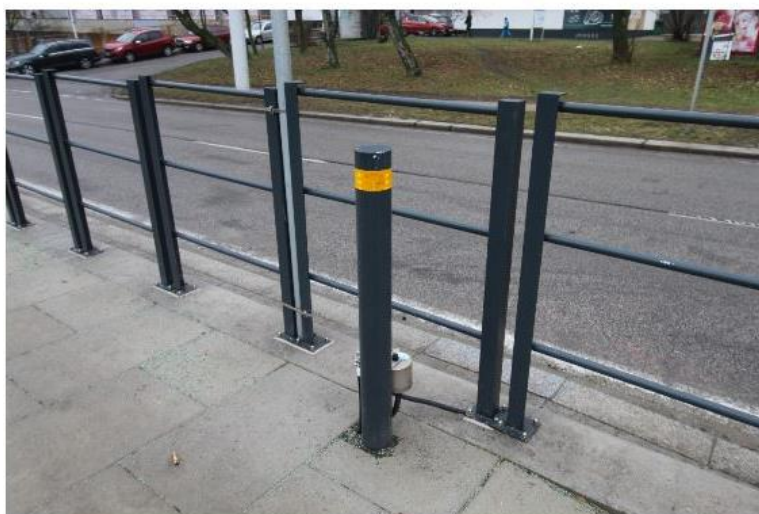
Obrázok 111_Príklad majáčka a nežiadúce riešenie ukoľajnenia
