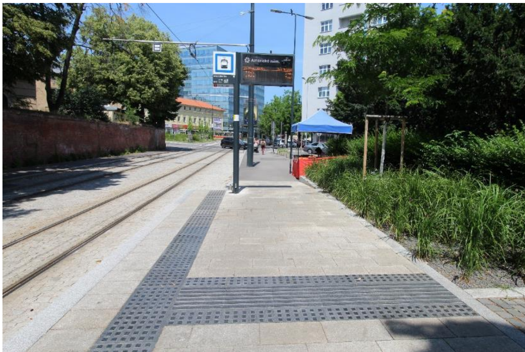
Obrázok 6_Príklad dláždenia povrchov na električkovom nástupišti v Úseku 1 – Americké námestie; dlažba na nástupišti – žulová platňa, varovný a signálny pás – žulová platňa s výstupkami a drážkami, farebnosť Impala, kryt koľajiska – stredná štiepaná dlažbová kocka
